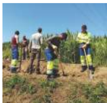
Chemin Vandrom - Dans le cadre de la lutte contre les inondations (coulées de boues), placement de fascines avec l'aide du Contrat de Rivière Senne
