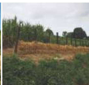
Chemin Vandrom - Dans le cadre de la lutte contre les inondations (coulées de boues), placement de fascines avec l'aide du Contrat de Rivière Senne
