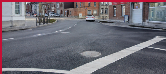
Le marquage au sol au carrefour de la Coulette a été posé.
