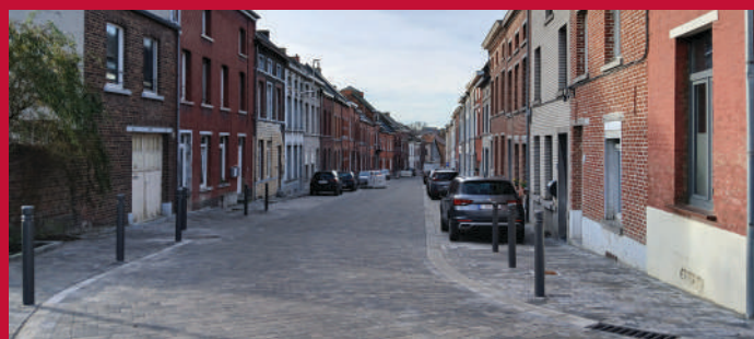
Les travaux à la rue du Moulin touchent à leur fin.
