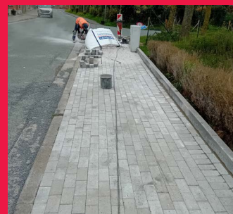
Rue Edouard Moucheron et Avenue de la Houssière / Trottoirs
