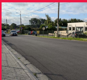
Rue des Frères Dulait / Pose du revêtement hydrocarboné
