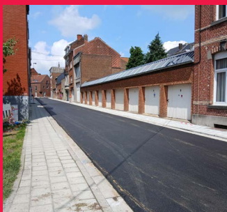
Rue Hector Denis / Remplacement des trottoirs et du revêtement de la voirie
