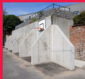
École de Ronquières / Mur de soutènement
