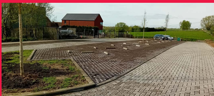
École de Steenkerque / Finalisation du parking
