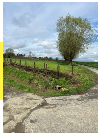
Placement de fascines afin de limiter les coulées de boue lors de fortes pluies.
