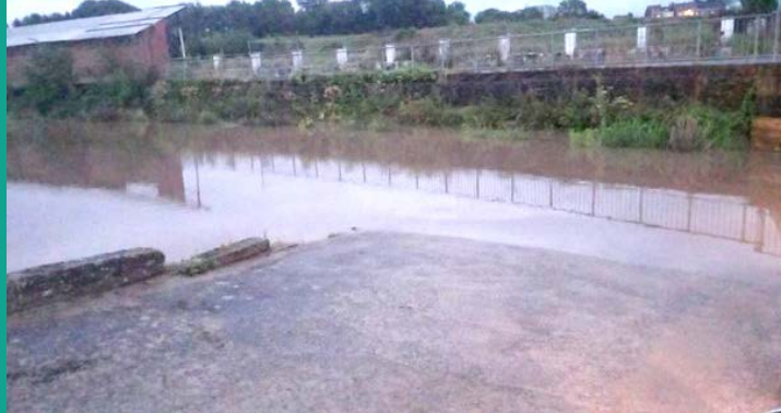
Débordement du Sans-Fond dans la zone d'immersion devant le terrain de foot à l'avenue du Stade
