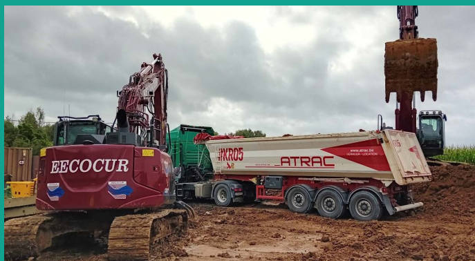
Construction de la ZIT du Rond-Point de la Bosse
