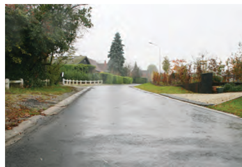
Rénovation de l'Avenue de la Hêtraie
