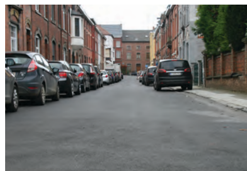
Rénovation de la rue de la Brainette
