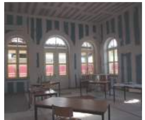
Finalisation de la nouvelle salle des pas perdus.
