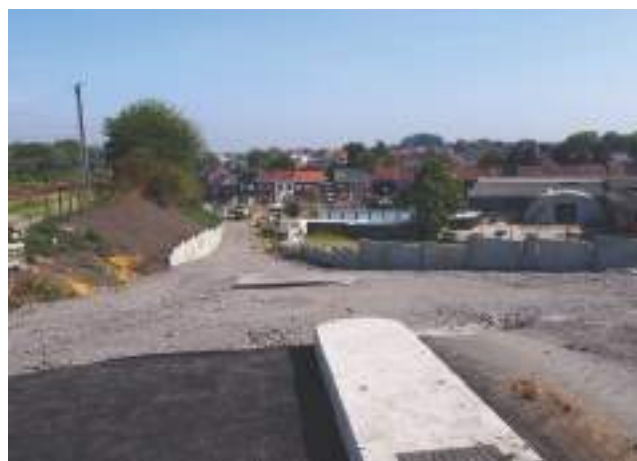
Voie d'accès du chemin de Feluy vers le nouveau parking.
