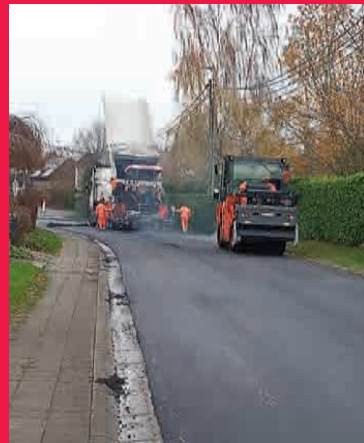
Pendant la pose du nouveau revêtement
