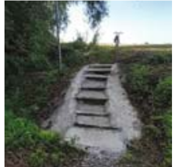
Réfection d'un escalier dans le Sentier Bois de Rebecq
