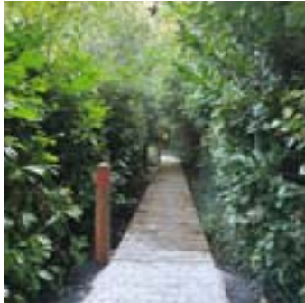
Création d'une passerelle au Sentier Marais à boue
